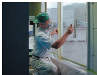
窓ガラス遮熱コーティング
