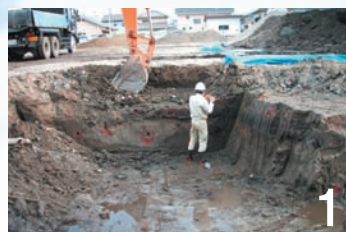
汚染土壌掘削除去
