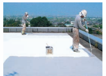
屋上遮熱塗装
