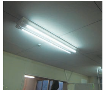
LED照明に交換
