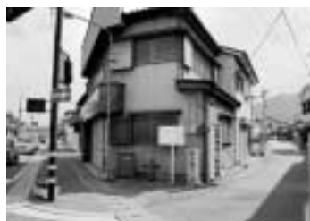
葦崎宿の船山橋近くにある、“鰍沢横町” (右の道路で、左は国道)
