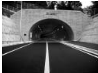
大月バイパス舗装工事
