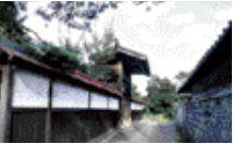
移築されて現存する長沢番所の門
