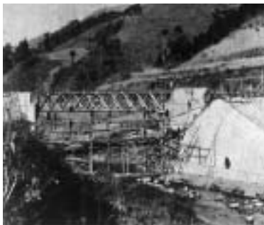
旧中央線敷設工事
