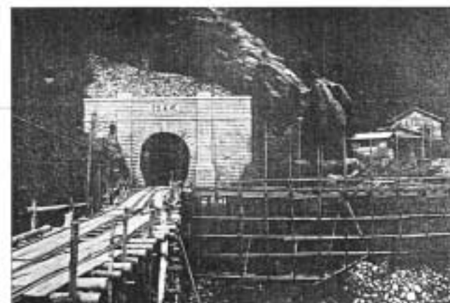
笹子隧道西口竣工 隧道は開通したがレールはまだ敷設されていない
