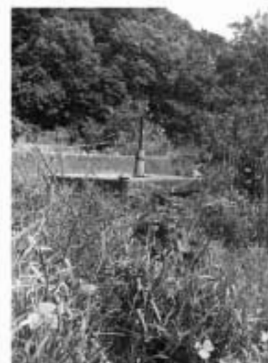
楯無堰取水口施設
