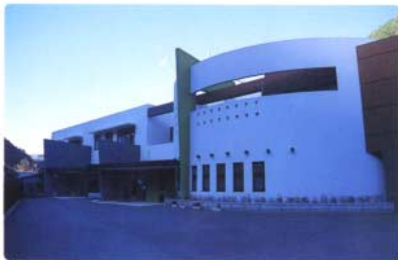
「上九一色村ふれあいセンター」 施工場所 西八代郡上九一色村 施 工 早野組・橋川建設JV
